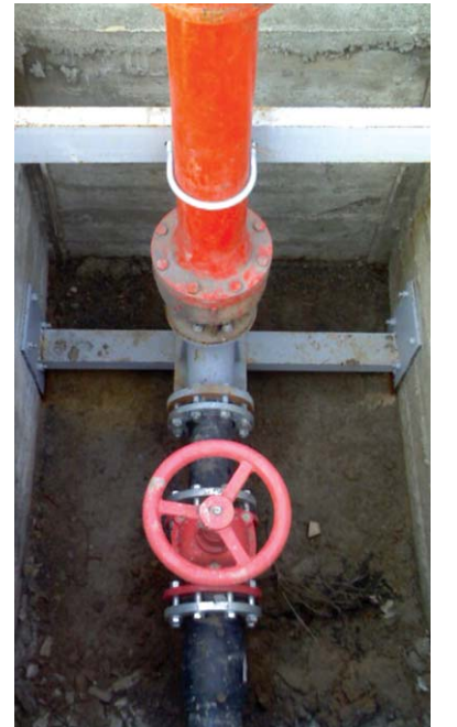
Hidrant montaj örneği
