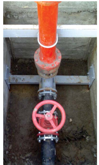
Hidrant montaj örneği
